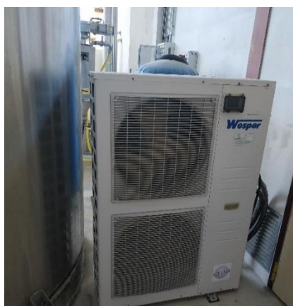
Photo n° 4 : Groupe froid pour distillation
