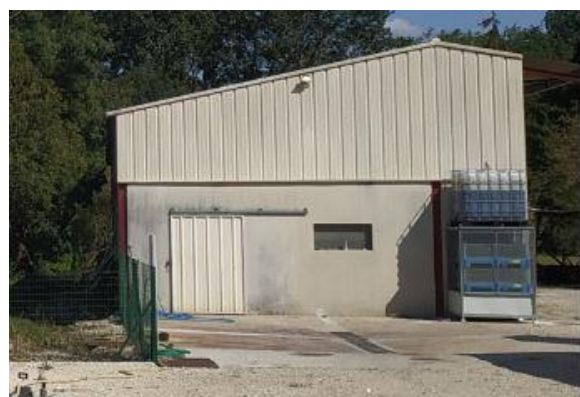
Photo n° 12 : les hangars agricoles et le local phytosanitaire
