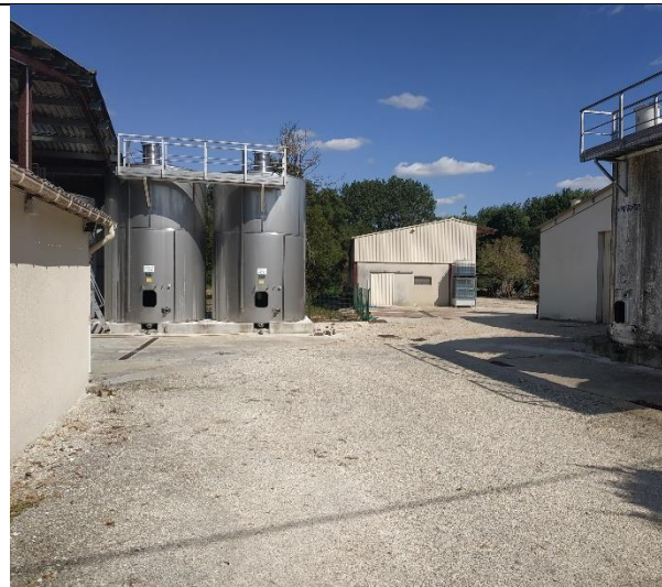
Photo n° 10 : Cuves de stockage de vins côté sud
